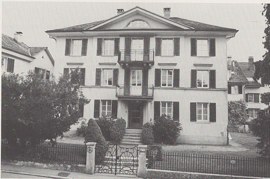
Ehemaliges Wohnhaus Guggenbühl (Ortsmuseum), Hauptansicht
