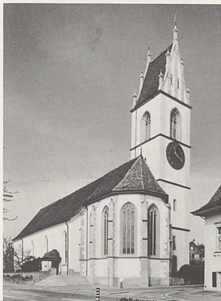
Ansicht von Südosten
